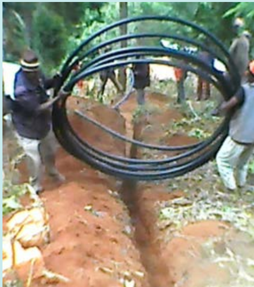
Beeld van de werkzaamheden voor de aanleg van de watervoorziening voor Makanya
